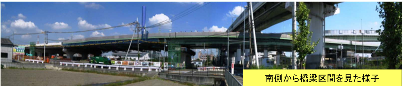
橋梁上から東側を見た様子
