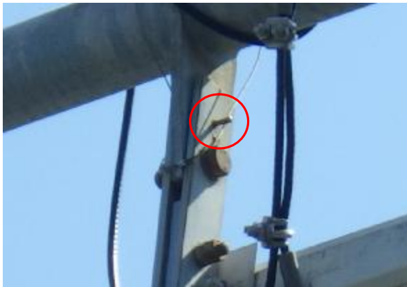
(a) 振れ止めピン（犠牲ピン）
