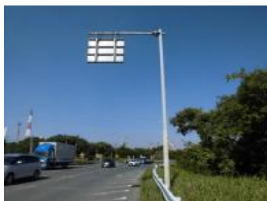
全景（終点より）
