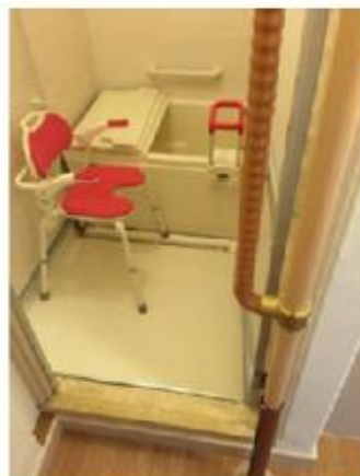
介護用椅子と手すりを設置した浴室
