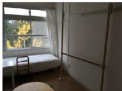
壁際に後付けの手すりを設置
