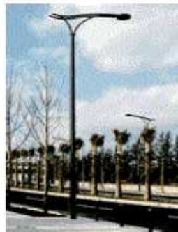
ハイブリッド街路灯 （太陽光&風力発電、LED照明、 非常用コンセント）
