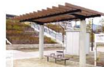
地中熱利用・太陽光発電・蓄電池 （休憩施設、災害時避難所）
