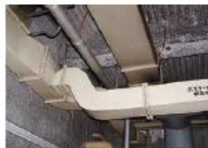
機械室の吹付け材
