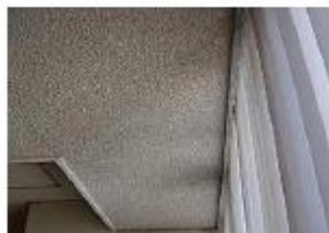
天井パーミキュライト仕上げ
