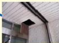
玄関横シャッター周り
