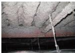
天井裏の吹付け材
