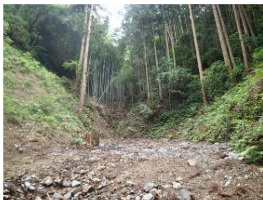
流木対策実施後
