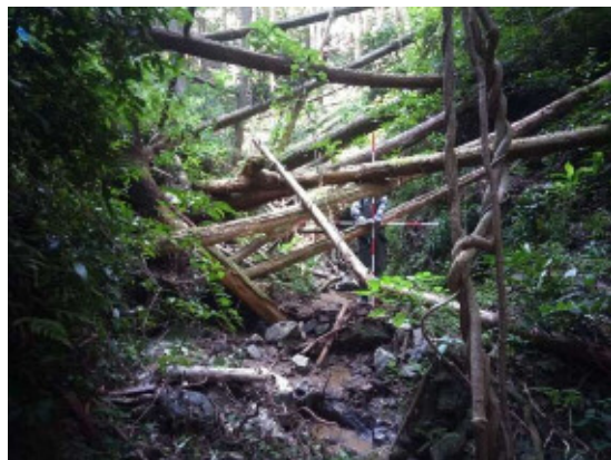
流木対策実施前
