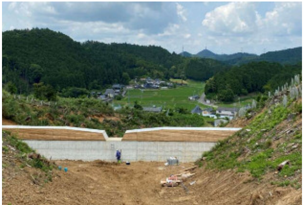
治山ダム（高槻市中畑地区）（上流より）
