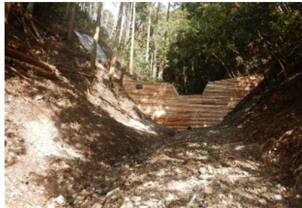
治山ダムと流木対策の実施状況（河内長野市岩瀬地区）
