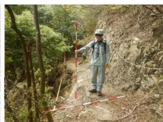
歩道の路肩が崩壊して通行が危険な状況
