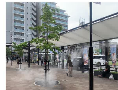
【暑熱環境改善設備（微細ミスト）整備事例】
