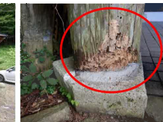
トイレの柱下部が老朽化により腐朽しており、構造上に損傷がある状況
