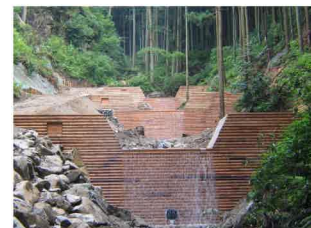
小規模治山ダムの階段状配置
