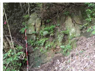
歩道斜面沿いに落石の恐れがある危険な状況
