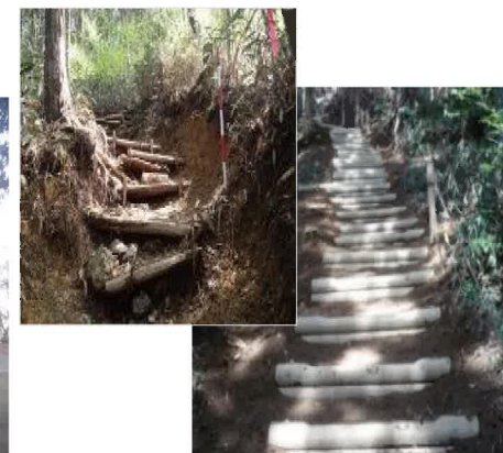
歩道の安全対策
