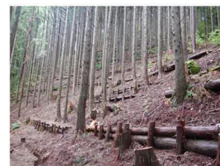
本数調整伐と筋工の施工
