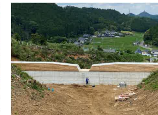
堆砂容量のある治山ダムの設置
