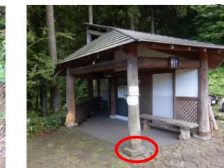
トイレの柱下部が老朽化により腐朽しており、構造上に損傷がある状況
