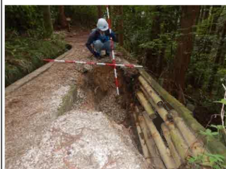
歩道の路肩が崩壊して通行が危険な状況
