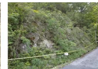
歩道斜面沿いに落石の恐れがある危険な状況
