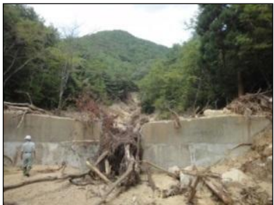
治山ダムによる土砂・流木の捕捉 (能勢町)
