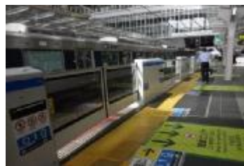
写真：可動式ホーム柵
