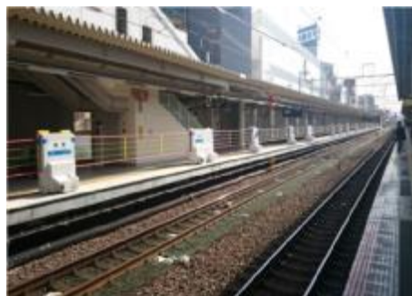
写真：昇降式ホーム柵の設置状況（JR高槻）
