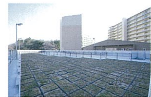
立体駐車場屋上のセダム緑化
