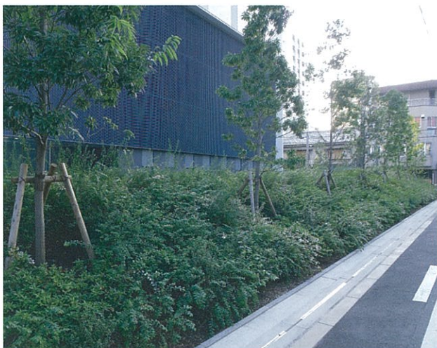
建築物の外観と地上部の緑化
