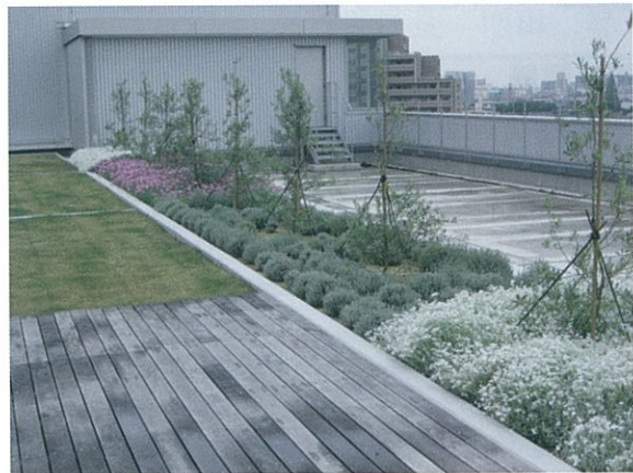
屋上部分の緑化
