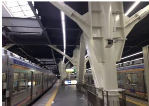
鉄道駅耐震補強の状況
