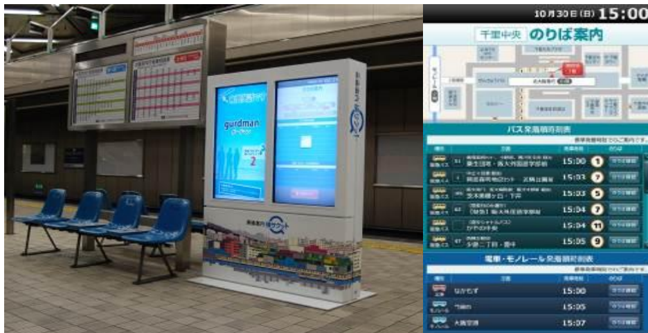
乗継案内モニターの設置状況（千里中央駅）
