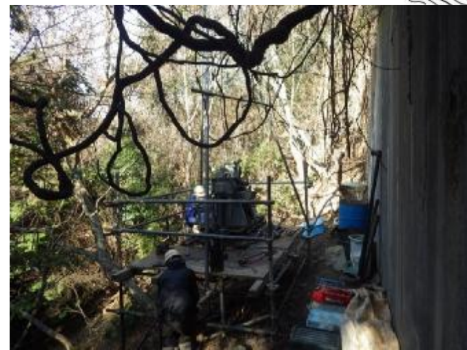
ボーリング調査
