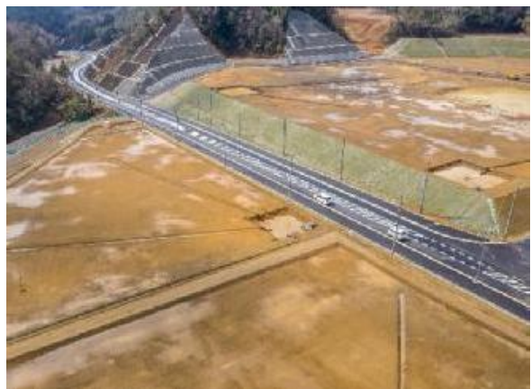
写真-2.6 箕面森町（施設誘致地区）を通る止々呂美吉川線
