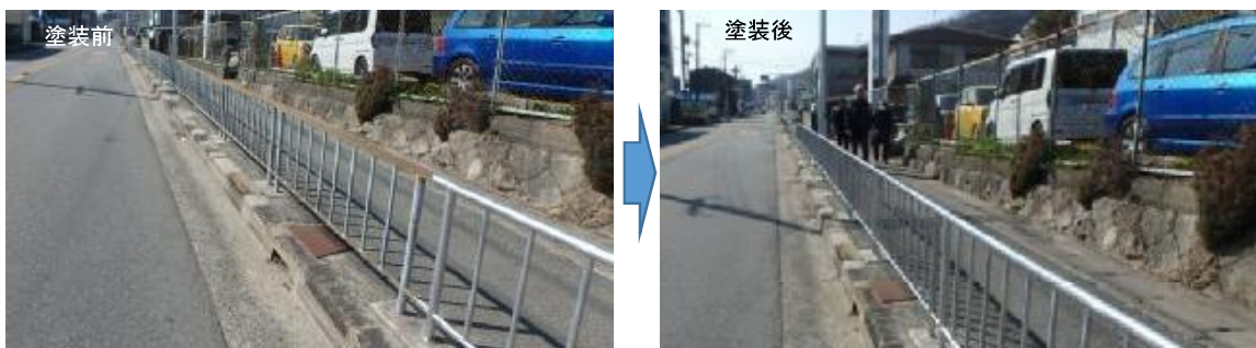
写真-3.30 横断防止柵の塗装（左：塗装前、右：塗装後）
