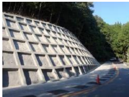
写真-3.20 道路防災工事 例
