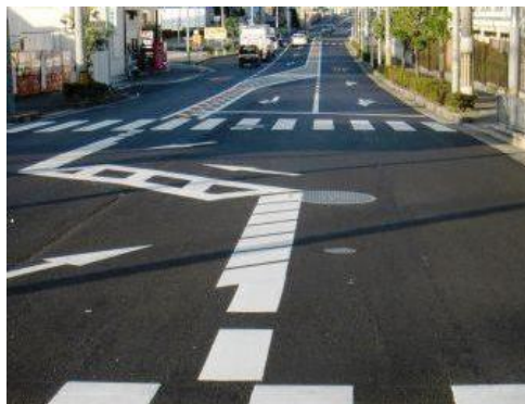
写真-3.19 舗装補修 例
