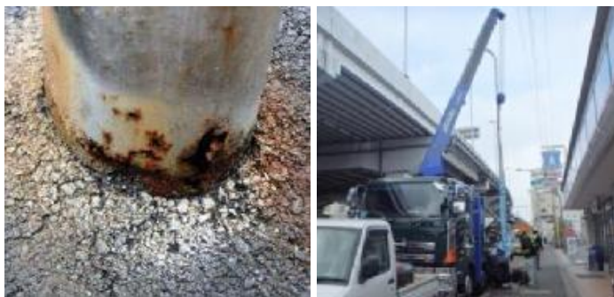
写真-3.21 照明更新例（左：照明柱根本腐食、右：更新工事）
