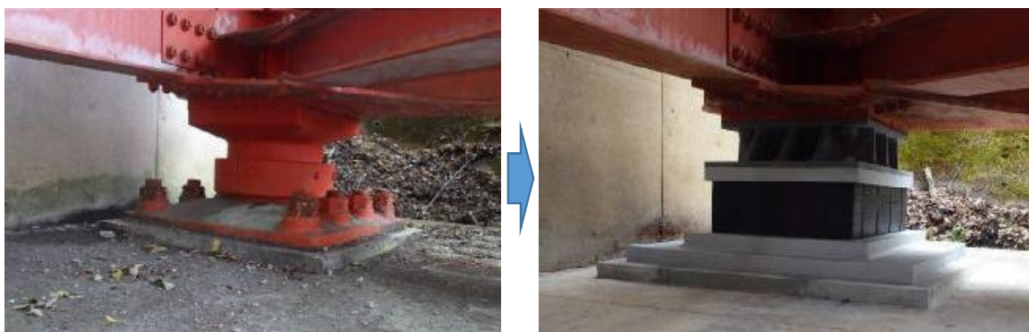
写真-3.17 橋梁耐震化工事例 支承の取替（左：着工前、右：着工後）
