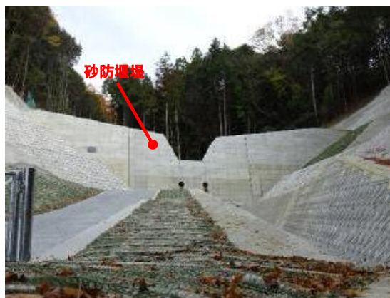
写真-3.11 砂防えん堤 整備例 川西谷(豊能町)
