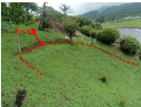
写真-3.13 地すべりの状況（野間西山地区 能勢町地黄）
