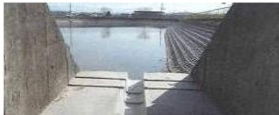
写真-3.14 余水吐の切欠き設置イメージ
