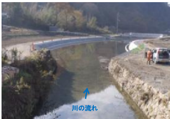
写真-3.8 田尻川 改修済区間(奥側)と未改修区間(手前側)
