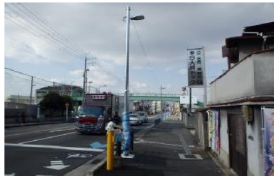
写真-3.6 歩道照明設置例（伊丹豊中線 岡町駅周辺）
