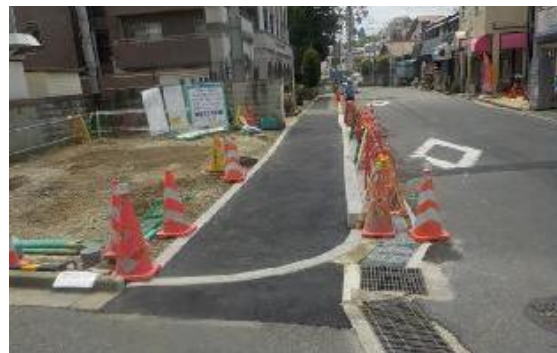
写真-3.4 桜井停車場線歩道整備箇所(箕面市桜井2丁目)
