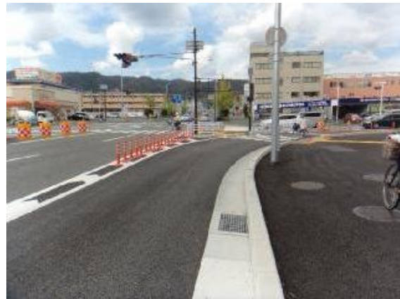
写真-3.1 現場写真 （坊島四丁目交差点 北向きに撮影）
