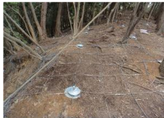
写真-3.7 国道423号 池田市伏尾地区 防災対策工事（左：施工箇所の状況、右：法面対策工事の状況）
