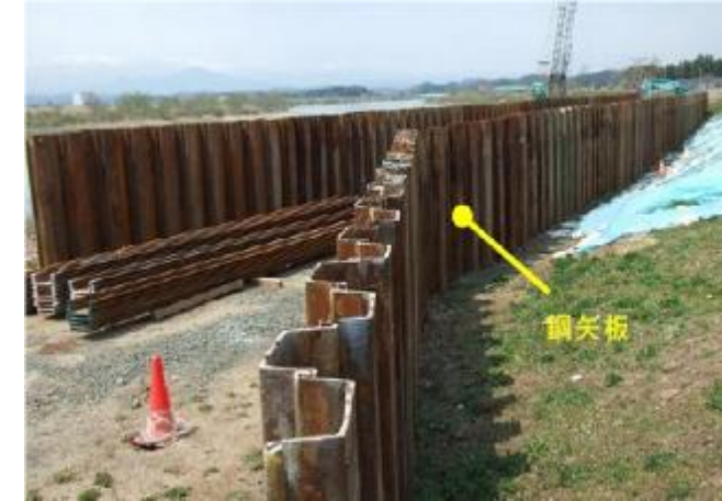
写真一堤防復旧の例
