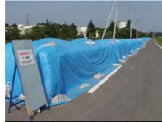
写真—堤防復旧の例
