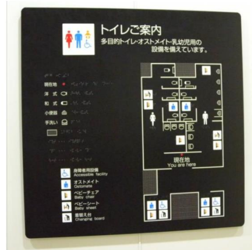
○便所の触知図案内板の設置例
