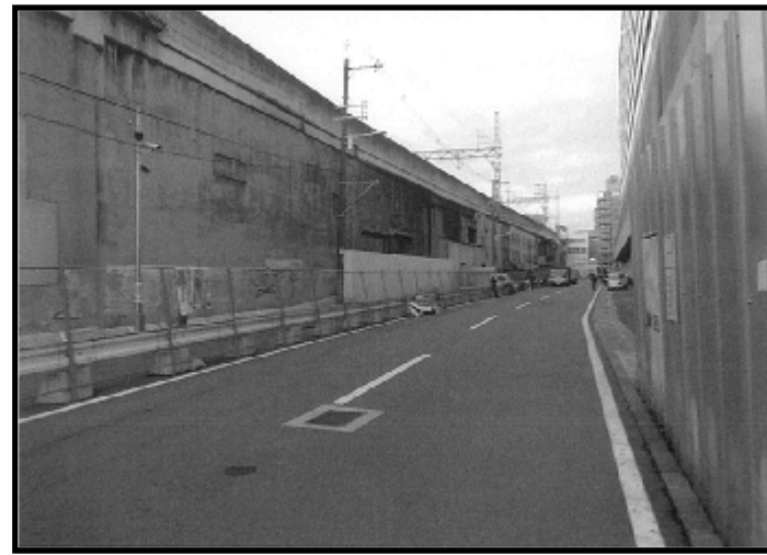
②敷地東側(現センター側)
