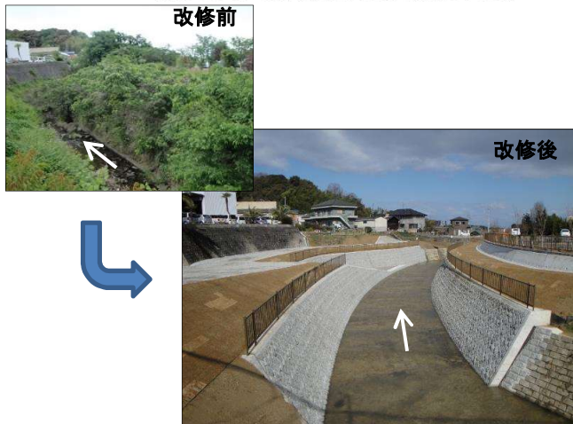
松尾川の改修（※⑥）和泉市
