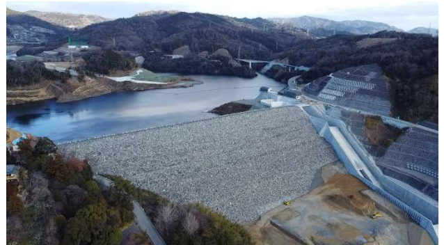
安威川ダム建設事業（※②）茨木市
