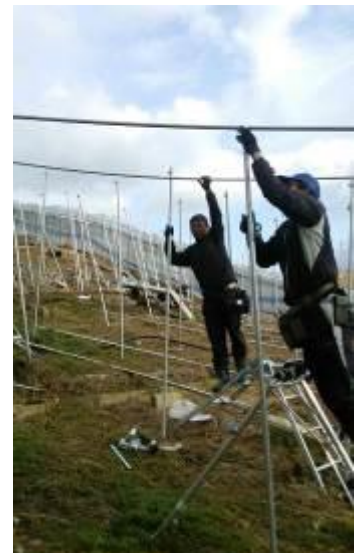
▲ハウス再建の様子
