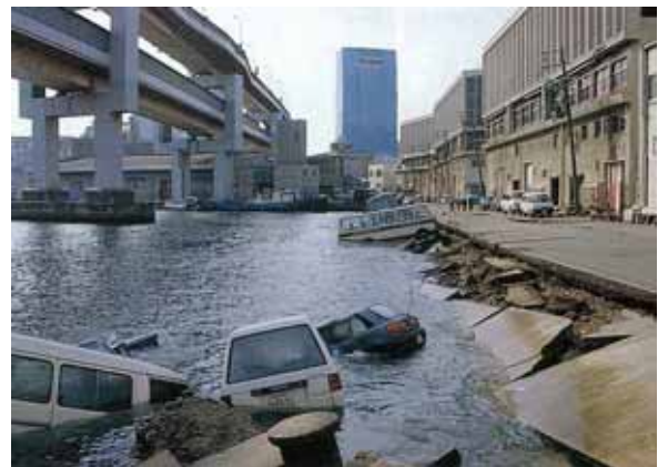
【 図2-41：港湾の被災状況 】
