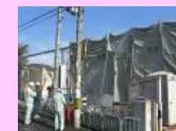
アスベスト解体現場パトロール
