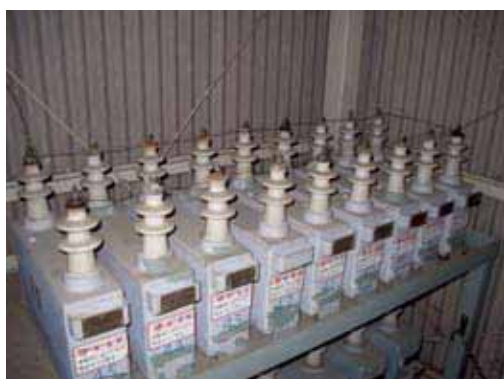
図-9 PCB含有コンデンサの保管
