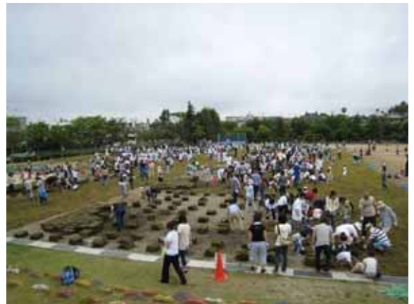
図-35 芝張り作業の様子
