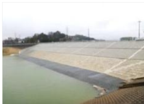
老朽ため池の改修
