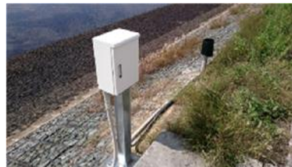
観測機器の設置
