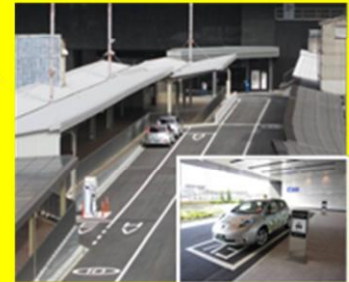
JR 大阪駅 EV・HV タクシー専用乗場 (大) 待機レーンと専用急速充電器 (小) EV タクシー専用乗場
