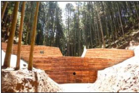
土石流発生を防止する治山ダムの整備（河内長野市天見地区）
