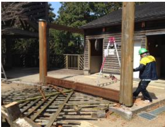
腐朽したパーゴラの撤去
