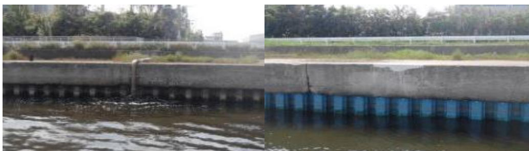
鋼矢板護岸（被覆防食工事施工前）
