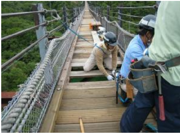
吊橋床板の交換
