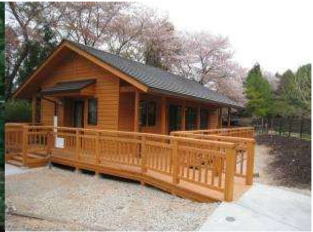
多目的活動拠点施設
