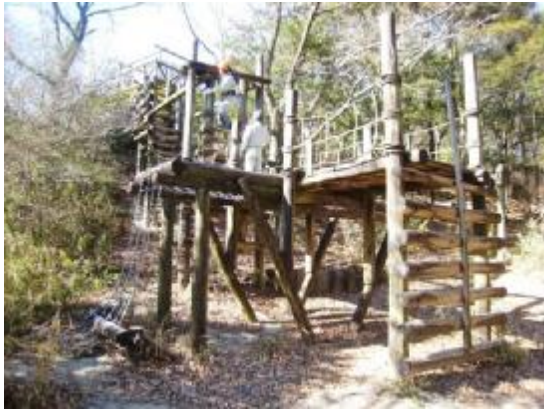
老朽化した遊具の撤去 作業前
