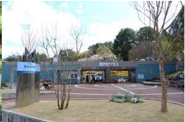
エントランスゲート
