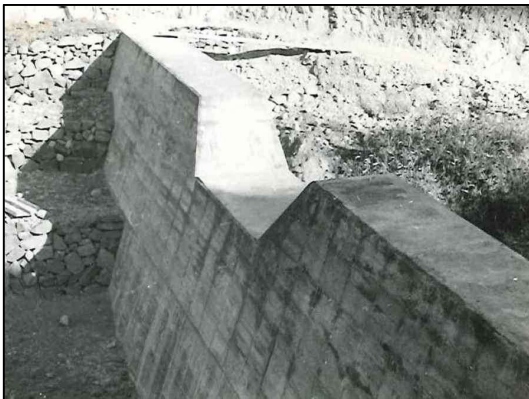
土石流を防ぐための治山ダム設置 【近年（昭和50年代以降）の治山施設】
