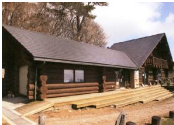
休憩所の屋根やデッキの改修
