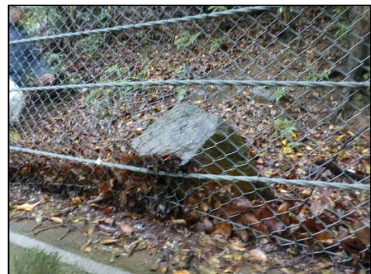
〔落石を捕捉した 落石防止よう壁〕 落石捕捉時や経年劣化により施設が損傷
