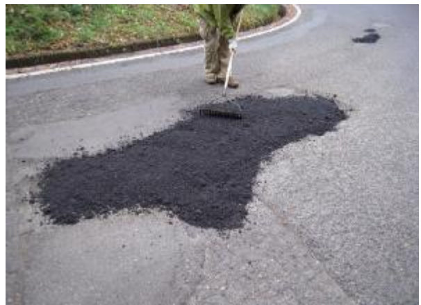
剥離したアスファルト舗装の補修
