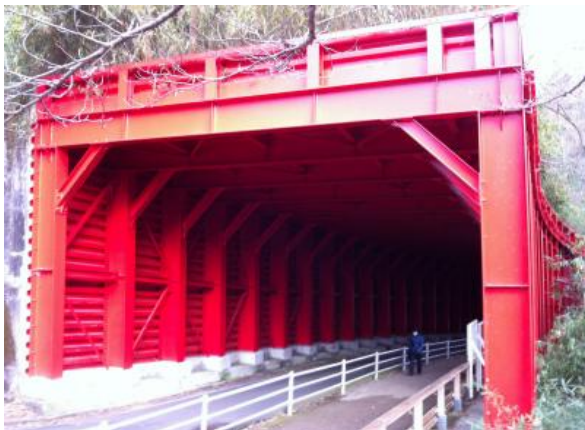
鋼製トンネルの塗装
